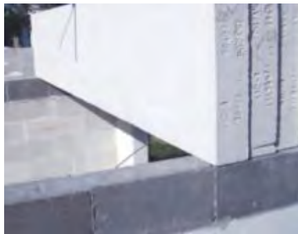
Fig. 5: Colocación de paquetes sobre muros cargadores.
